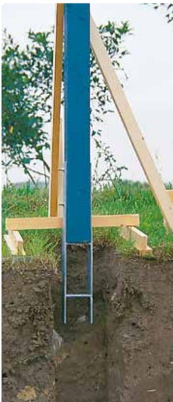
Pfostenanker zum Einschlagen bieten die schnellste Art, einen Pfosten zu setzen. Empfehlenswert sind diese vor allem für Vorgartenzaunanlagen.
