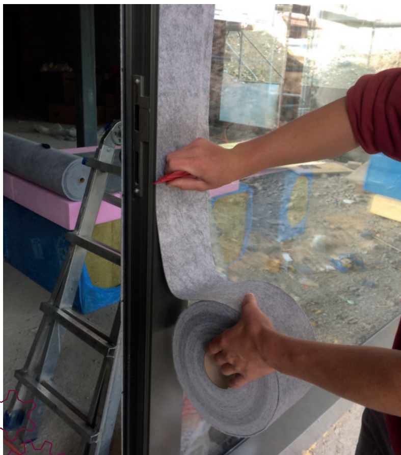
Vollblechtüre geschützt – einfaches und rasches Anbringen dank masskonfektionierter Rolle
