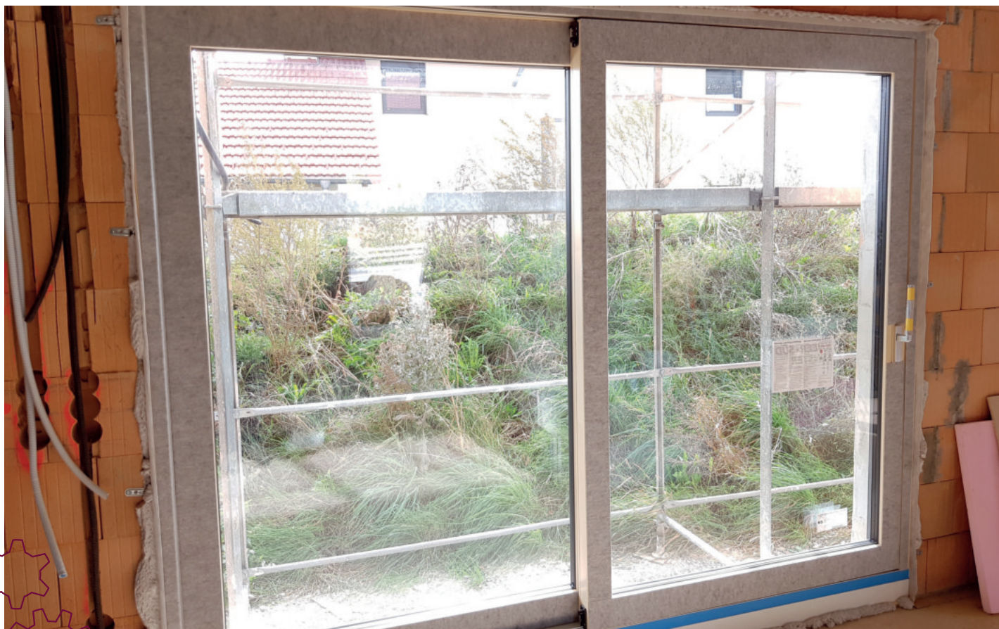
Schutzmassnahme im Neubau während der Bauphase. ALLPROTECT Flex als Schutzlösung für eine Hebeschiebetüre aus Holz, Fichte farblos lackiert.
