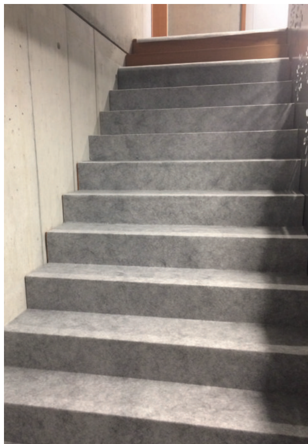
Geölte Eichenholz-Treppe mit ALLPROTECT geschützt
