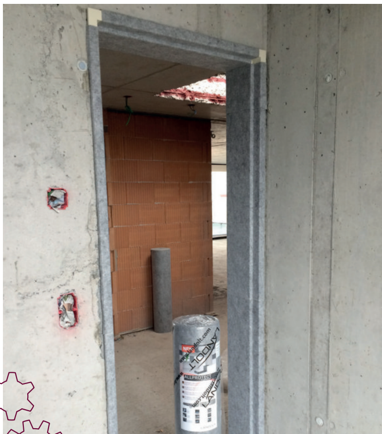
Stahlzarge passgenau geschützt
